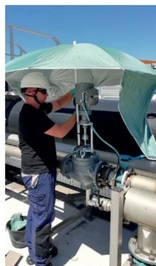
Juillet 2022 : installation de 14 parasols sur les 14 vannes de régulation de la biofiltration qui étaient en "défaut température" lié à la canicule. Depuis, des protections pérennes ont été mises en place.
