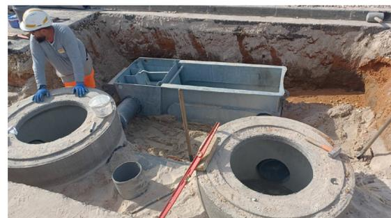
Cet ouvrage, pesant 1 tonne et mesurant plus de 2 mètres de long et de hauteur, permet de prétraiter les eaux pluviales de ruissellement et donc de limiter la pollution du milieu naturel.
