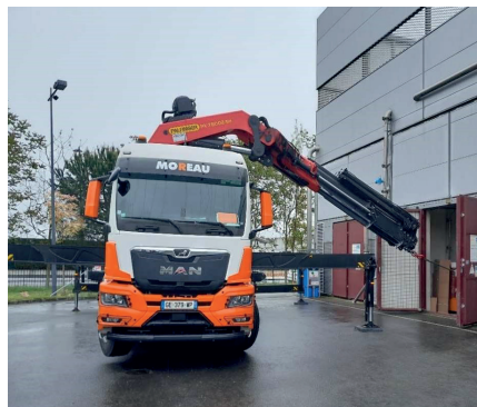
Grue utilisée pour l'enlèvement du moteur.
