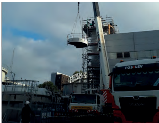
Découpe et dépose du dôme silo
