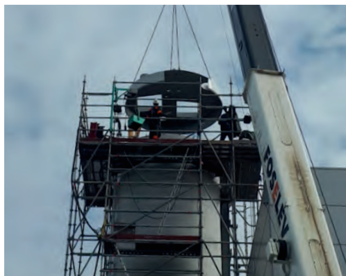
Pose du nouveau dôme
