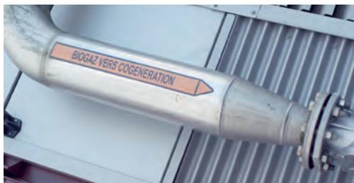
Avant son utilisation, le biogaz est traité afin d'éliminer le sulfure d'hydrogène, gaz non désiré. L'unité de traitement de désulfuration du biogaz doit être renouvelée.
